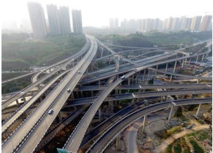
Autobahn-Kreuzung in China mit fünf Ebenen.
